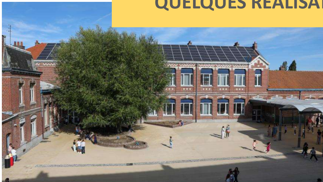
Ecole Quinet Bert une installation photovoltaïque en autoconsommation
