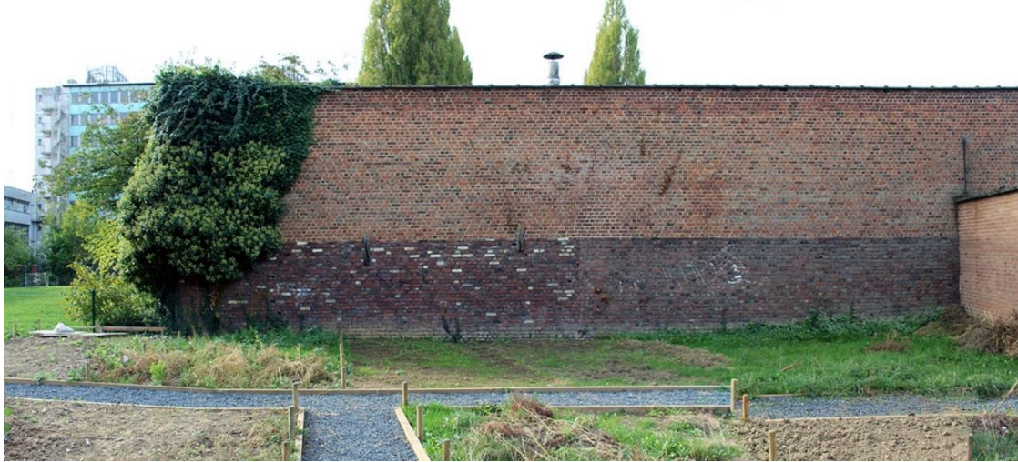
PHOTOS DU SITE AVANT TRAVAUX :
